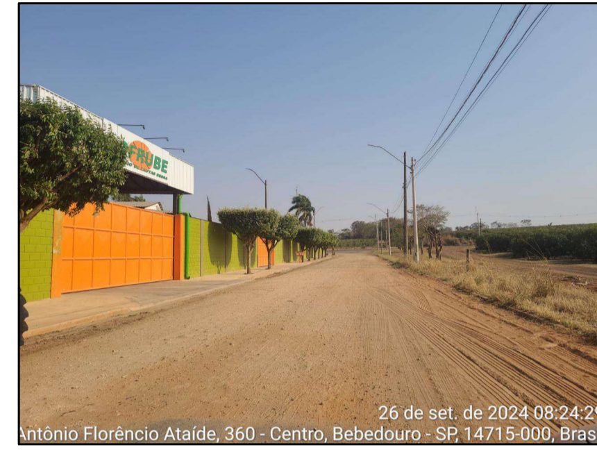
Rua Antônio Florêncio Ataíde, confluência com a Rua Manoel Guerreiro. Pavimentação rampa de acessibilidade.
