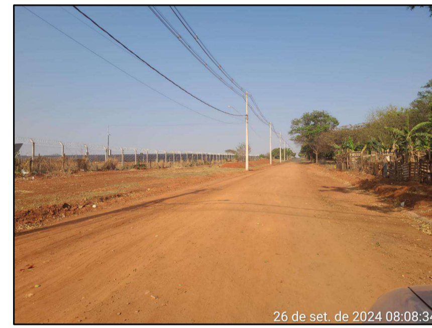
Rua Geraldo Ferreira, confluência com a Rua da Fé. Execução de guia e sarjeta, rampa de acessibilidade, calçada e pavimentação.
