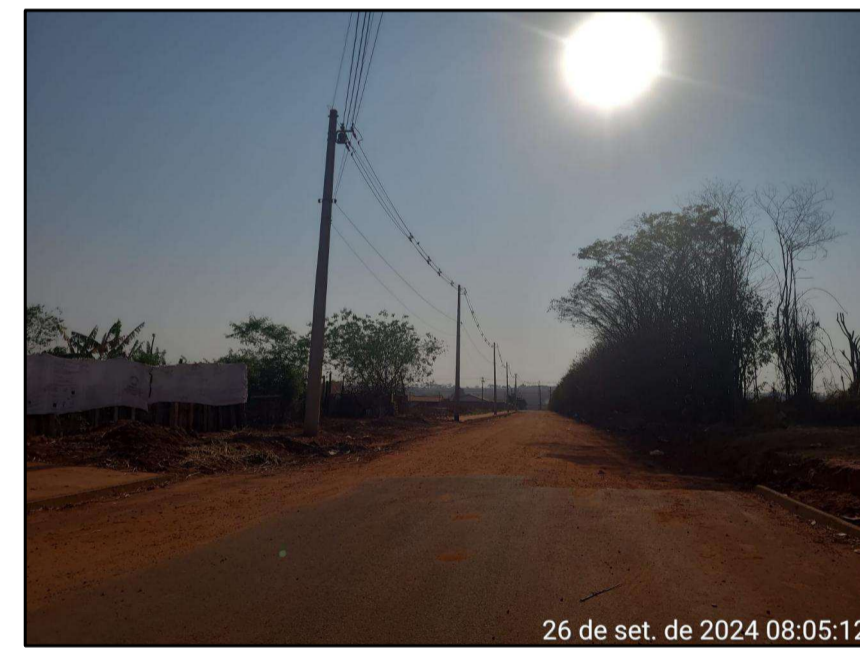
Rua Geraldo Ferreira, confluência com a Rua dos Missionários. Execução de guia e sarjeta, rampa de acessibilidade, calçada e pavimentação.
