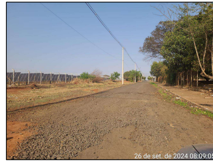
Rua Geraldo Ferreira, confluência com a Rua da Prudência. Execução de calçada.
