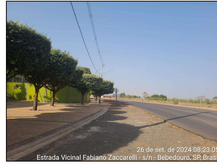
Vicinal Fabiano Zaccarelli, confluência com a Rua Antônio Florêncio Ataíde. Pavimentação e rampa de acessibilidade.
