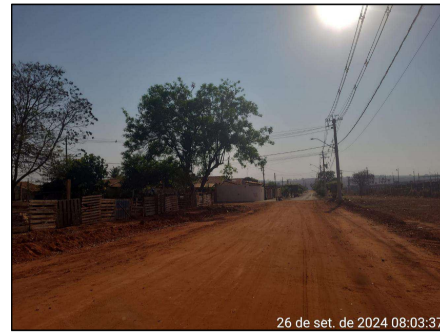
Rua Geraldo Ferreira. Execução de guia e sarjeta, rampa de acessibilidade, calçada e pavimentação.
