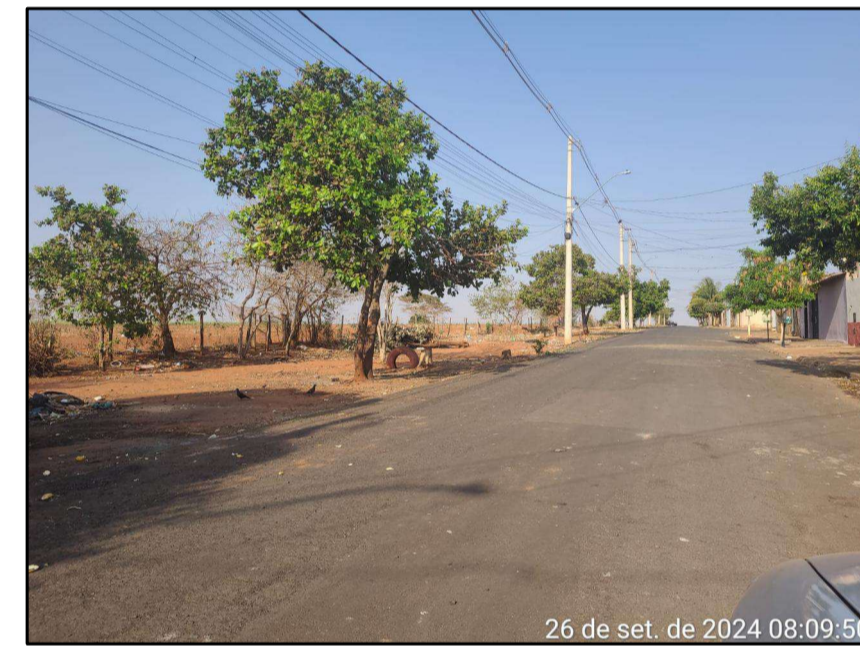
Rua Geraldo Ferreira, confluência com a Rua Lamartine Godoy. Execução de calçada.
