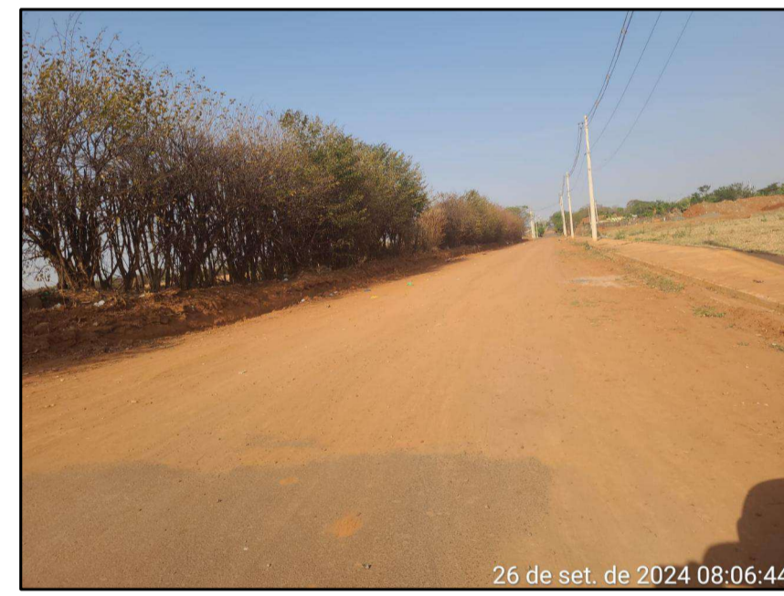
Rua Geraldo Ferreira, confluência com a Av. Maria Dias. Execução de guia e sarjeta, rampa de acessibilidade, calçada e pavimentação.
