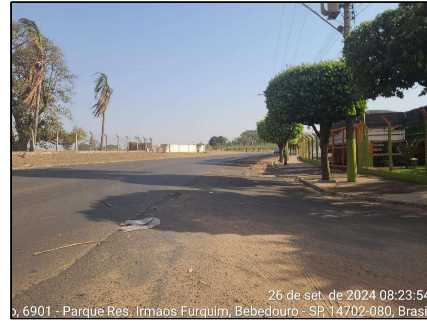
Vicinal Fabiano Zaccarelli, confluência com a Rua Manoel Guerreiro. Pavimentação e rampa de acessibilidade.
